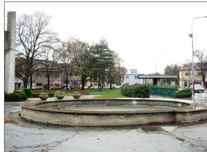
Do roka bude na hulínské náměstí mnohem hezčí pohled než je nyní. Rekonstrukce náměstí začne na jaře a některé změny budou opravdu razantní.
