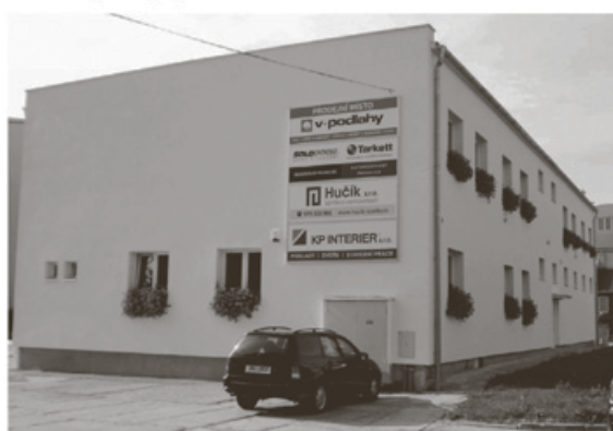
Opravená budova sídla firmy na ulici Albertova v Kroměříži.
