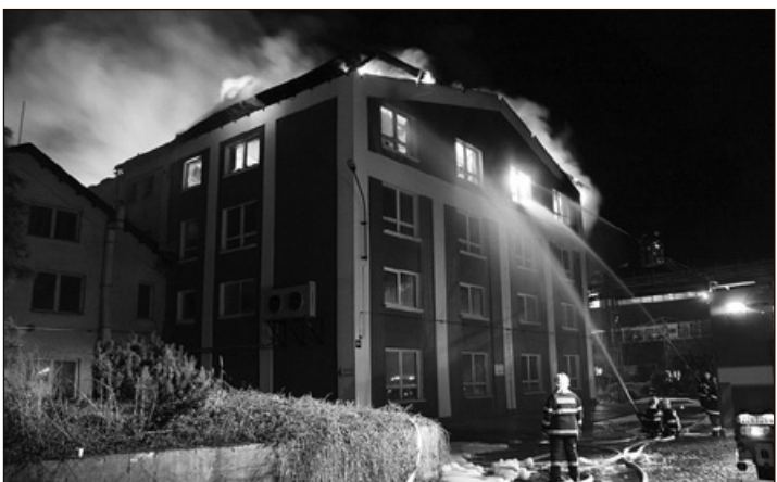
S požárem během čtyř dnů bojovali hasiči ze 67 jednotek profesionálních, dobrovolných i podnikových sborů čtyř krajů. Šedesát hodin hasičům trvalo, než se dostali k poslednímu velkému a skrytému ohnisku požáru pod sutinami a troskami zřícených budov. Zásadní podíl na tomto úspěchu mělo rozhodnutí o nasazení specialistů hasičů z útvaru Hlučín s těžkou technikou. Během záchranných prací byli dva hasiči středně těžce zraněni. Majitel firmy Remiva Miroslav Vala vyjádřil velké poděkování všem hasičům a záchranářům, kteří nepřetržitě a s obrovským nasazením pomáhali při likvidaci požáru. Jejich zásluhou nedošlo ke ztrátám na životech a zároveň byl ochráněn majetek okolních firem. Foto: Archiv HZS
