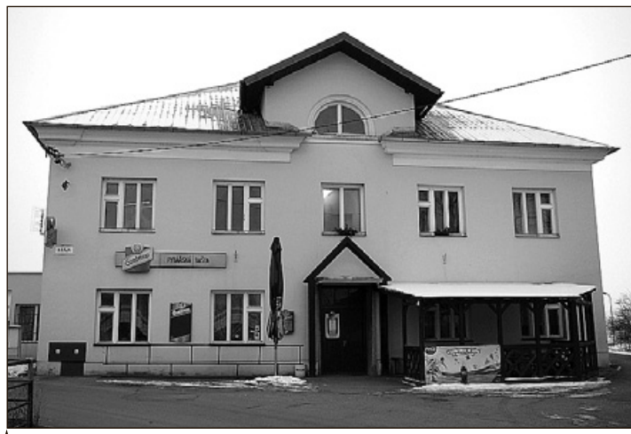
Objekt v blízkosti kroměřížského Bagráku s restaurací Rybářská bašta má ustoupit plánované trase jižního obchvatu Kroměříže. Nikdo však neví, zda se vůbec někdy najdou peníze pro stavbu zvolené trasy obchvatu, na jejíž nesmyslnost mnozí poukazují již nyní. O šanci, zda trasa může vést jinudy, se bude teprve jednat. Na příští schůzi zastupitelstva Kroměříže, které bude ve čtvrtek 24. března, je pozván architekt, který má podat bližší informace o plánované trase. Jednání zastupitelstva je veřejné.
